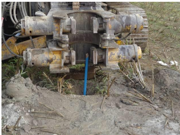
Posa piezometro in foro di sondaggio
